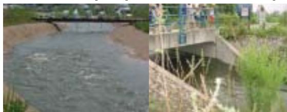
図0 出水実験で児童が撮影したと出水河川の現場体験写真
