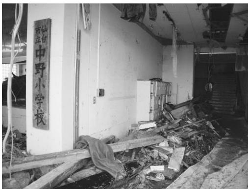
写真1 津波による被害の様子
